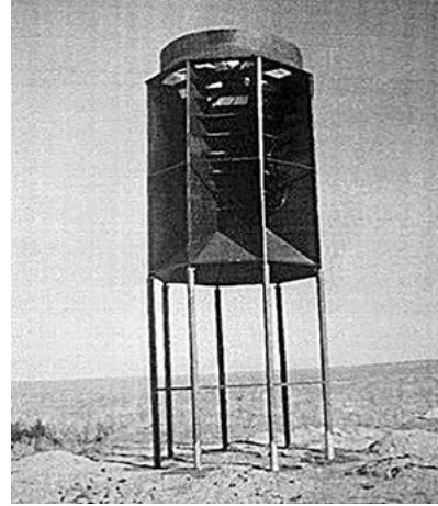
Рисунок 5 – Опытная башенная ветро-солнечная электростанция «Торнадо» мощностью до 3 кВт [150]
