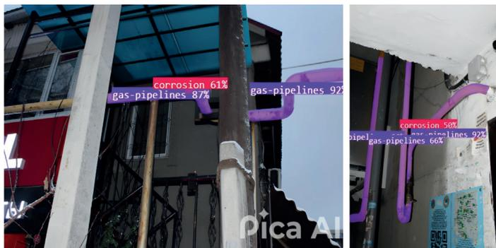
Рисунок 3 - Пример детекции коррозии и элементов газовой сети в закрытом пространстве с использованием обученных моделей
