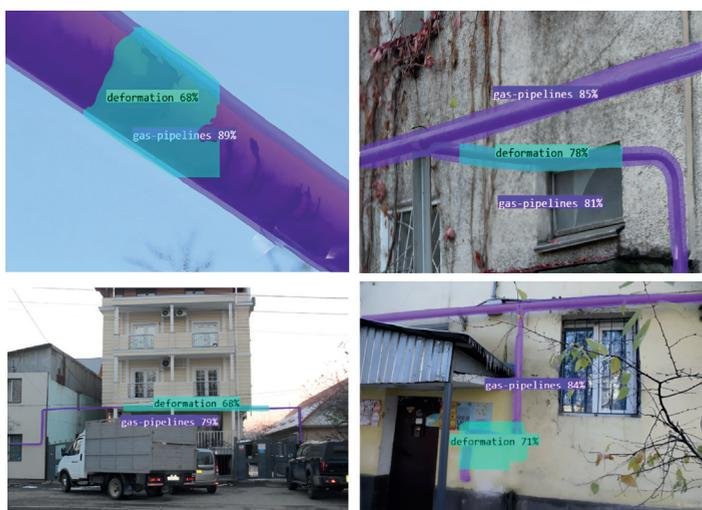
Рисунок 4 - Пример автоматического обнаружения деформаций на наружных газопроводах с использованием обученных моделей
