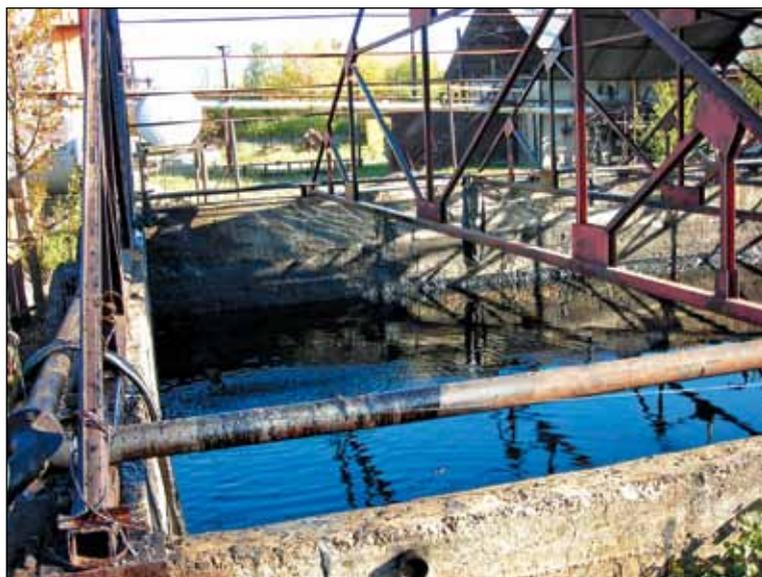
Рисунок 9 — Технологическая бетонная яма продукта первичной обработки (группой гидроциклонов) (12×14×4)
