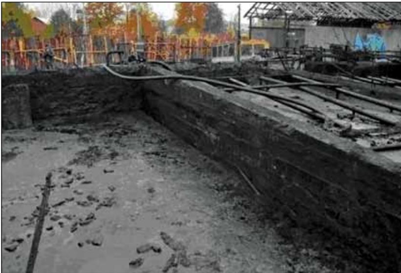
Рисунок 3 — Приемная бетонная яма (размер 12×14×4) с теплообменным радиатором-нагревателем
