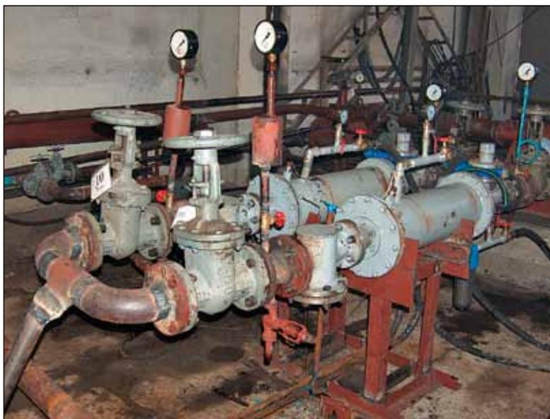
*Рисунок 8* — Наномолекулярный реактор обработки высокочастотным магнитным полем индуктивности спаренный
